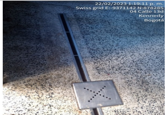
Foto No.4. Cárcamos, rejillas
