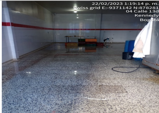
Foto No.3. Área de trabajo
