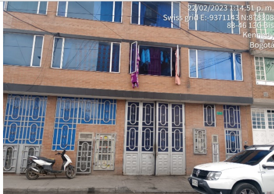
Foto No.1. Fachada del predio
